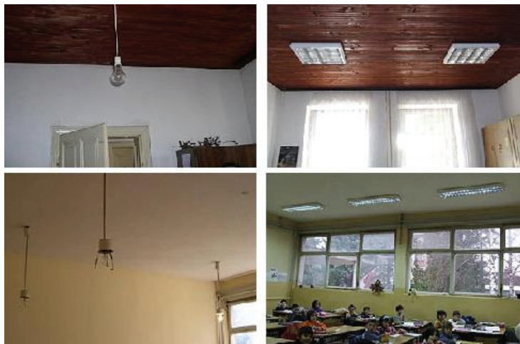
Слика В14 Пример модернизације унутрашњег осветљења у јавној згради, стање пре и стање после
