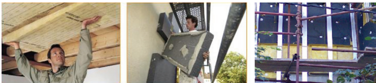
Слика В10 Постављање изолације на таваницу подрумске просторије и на фасадни зид
