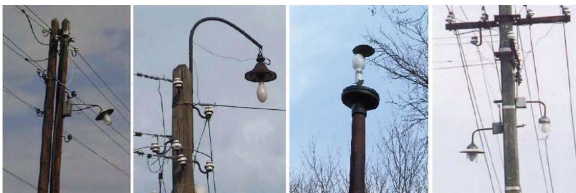
Слика В 15 Примери лошег стања јавног осветљења у општинама Србије
